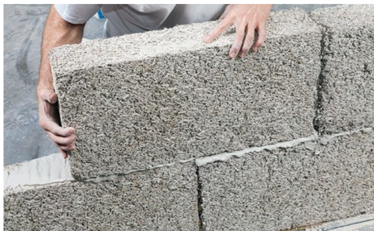
Блоки з конопляного бетону, виготовлені з конопляного лушпиння та вапна. Вони забезпечують високий акустичний та тепловий комфорт, а також високу вогнестійкість.
