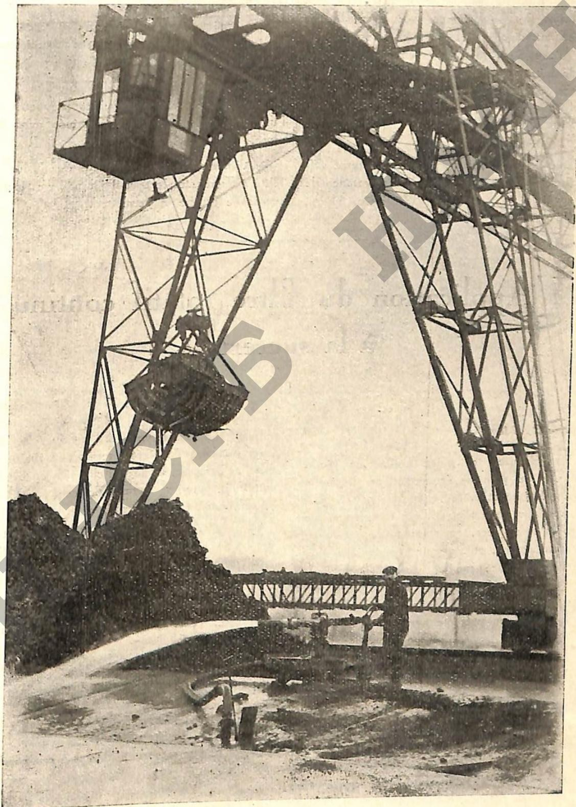
Stockage de betteraves par benne preneuse sur plate-forme en ciment et alimentation des caniveaux à la mitrailleuse.
