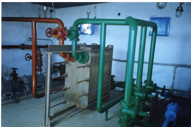
Рис. 6.11. Пластинчастий теплообмінник
