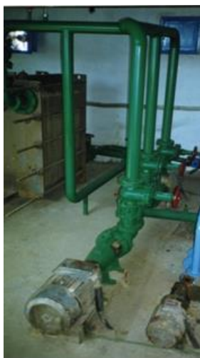
Рис. 6.12. Елементи геотермальної циркуляційної системи: а – мережевий насос та насос для підживлення; б – газопоршневий двигун з електрогенератором та газовий сепаратор
