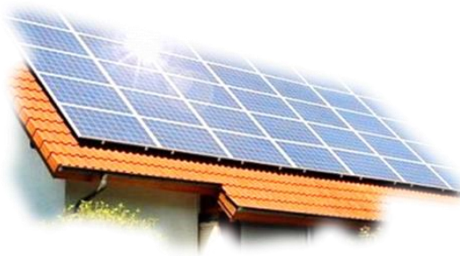
Рис. 3.16. Дахова сонячна електростанція
