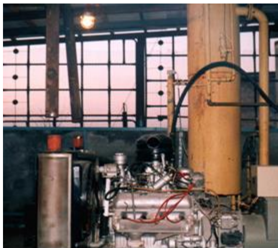
Рис. 6.12. Елементи геотермальної циркуляційної системи: а – мережевий насос та насос для підживлення; б – газопоршневий двигун з електрогенератором та газовий сепаратор
