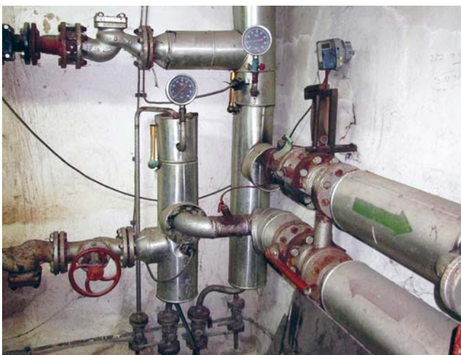
Теплова станція 'ВКС' до реконструкції.
