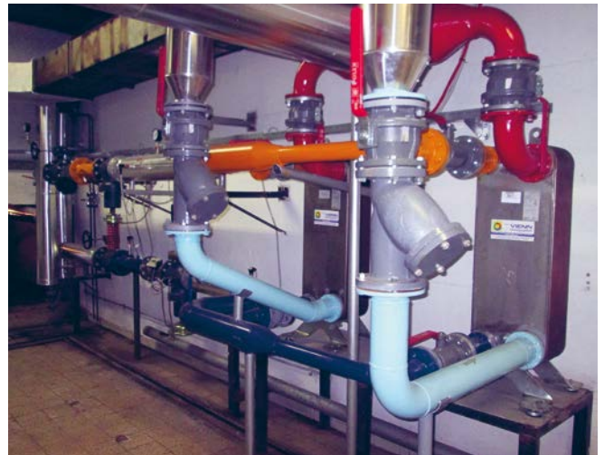
Тепловий пункт «СКПК Мейдан» після реконструкції
