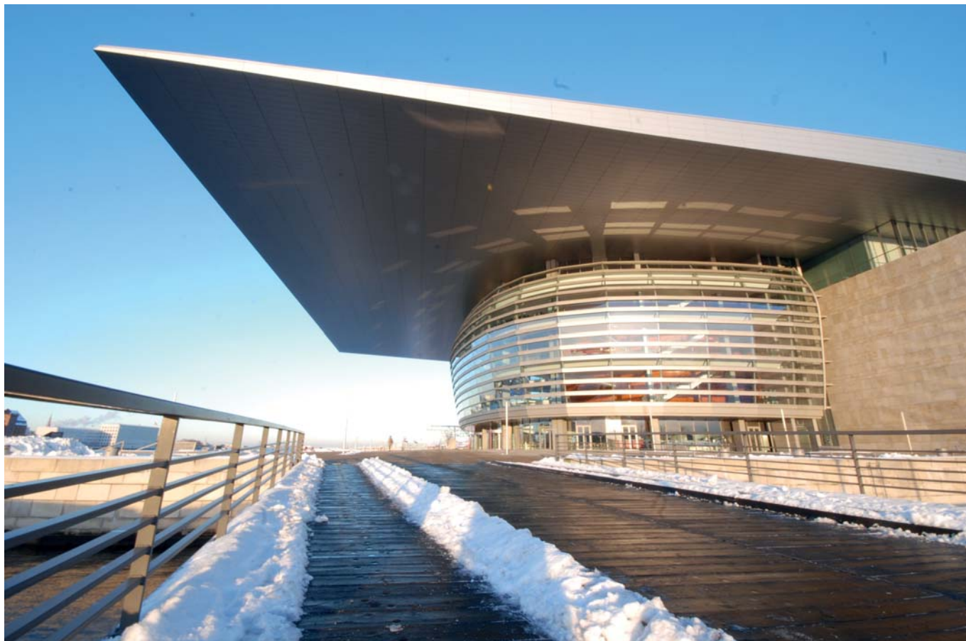
Практичне відображення роботи системи сніготанення
